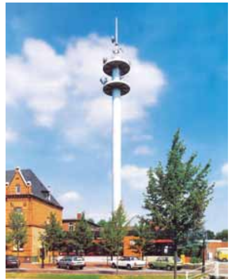
Etwa 20 Funktürme des größeren Typs sind mit Aufzügen ausgestattet. Rund 20 Türme der kleineren Bauart sind neben etlichen Gittertürmen mit innen liegenden senkrechten Steigleitern zu erklimmen.
